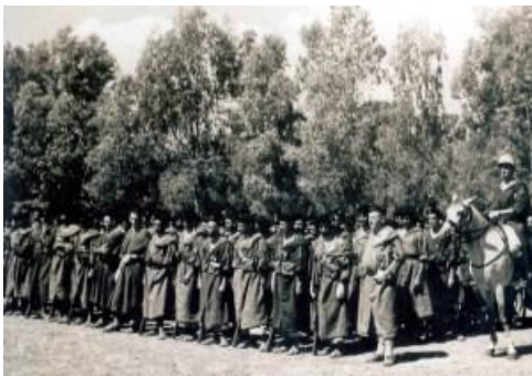
Reparti di Gourmiers.
